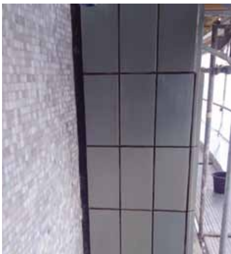
Eine keramische Wandfläche vor und nach der Reinigung.
